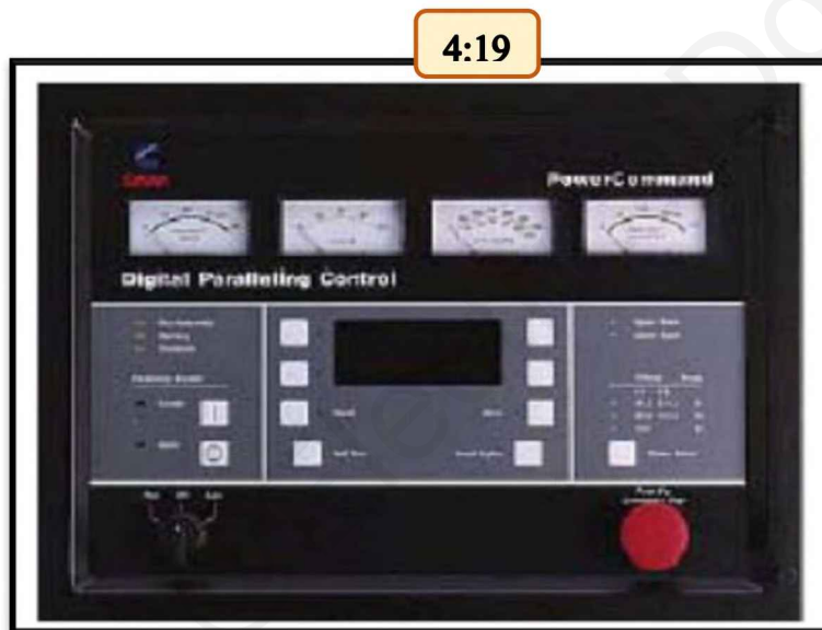
شکل ۲۶. سیستم ریز پردازشگر "پاور کامند"
