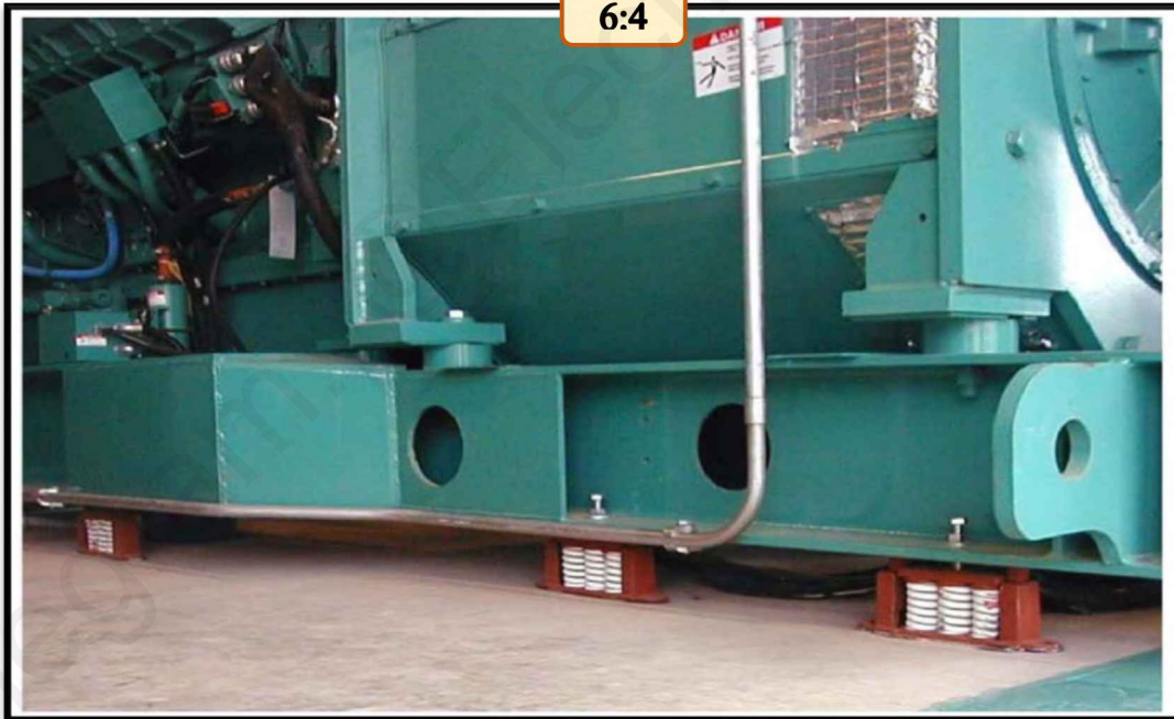
شکل ۵۲. دستگاه مولدی سوار بر ایزوله گر های لرزش نوع فنر
