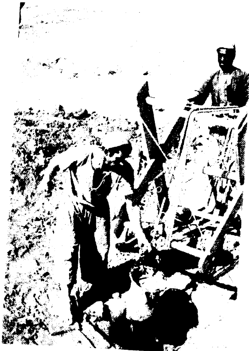
شکل ۱- حفاری دستی به وسیله مقنی با استفاده از ابزارهای ابتدایی
